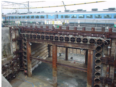
圖 1-5 管幕支撐工法參考案例照片
