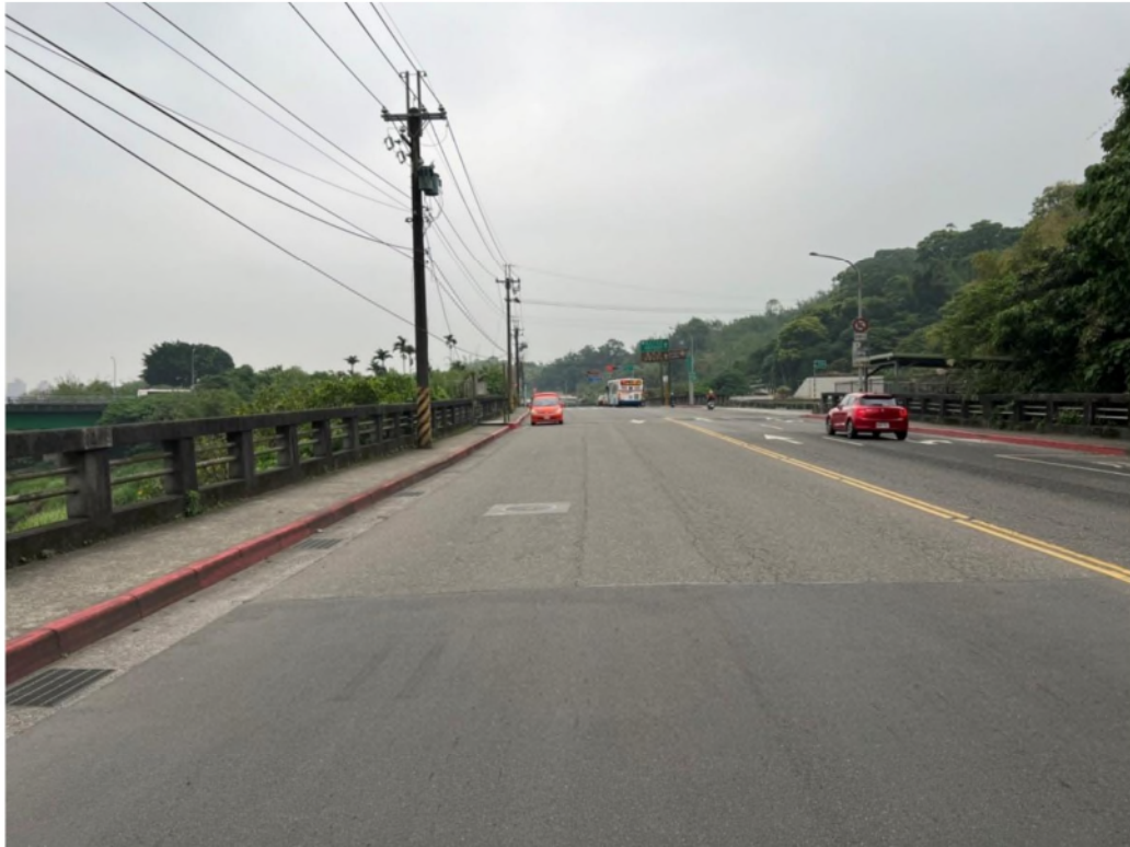
照片 5：文山區木柵路五段 43 巷對面道路現況
