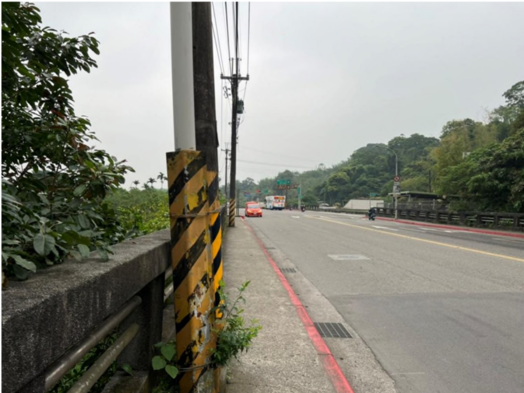
照片 4：文山區木柵路五段 43 巷對面道路現況
