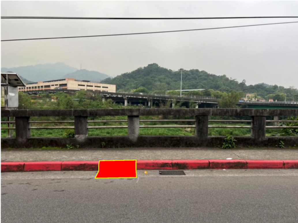
照片 1：文山區木柵路五段 43 巷對面道路現況
