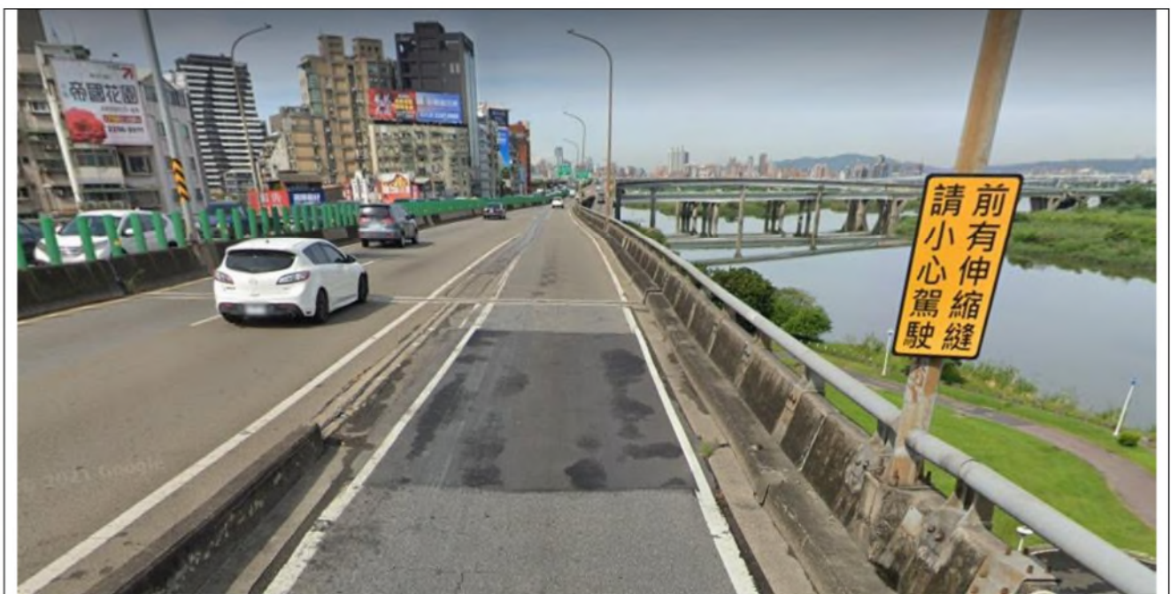
環河高架道路(往南)
