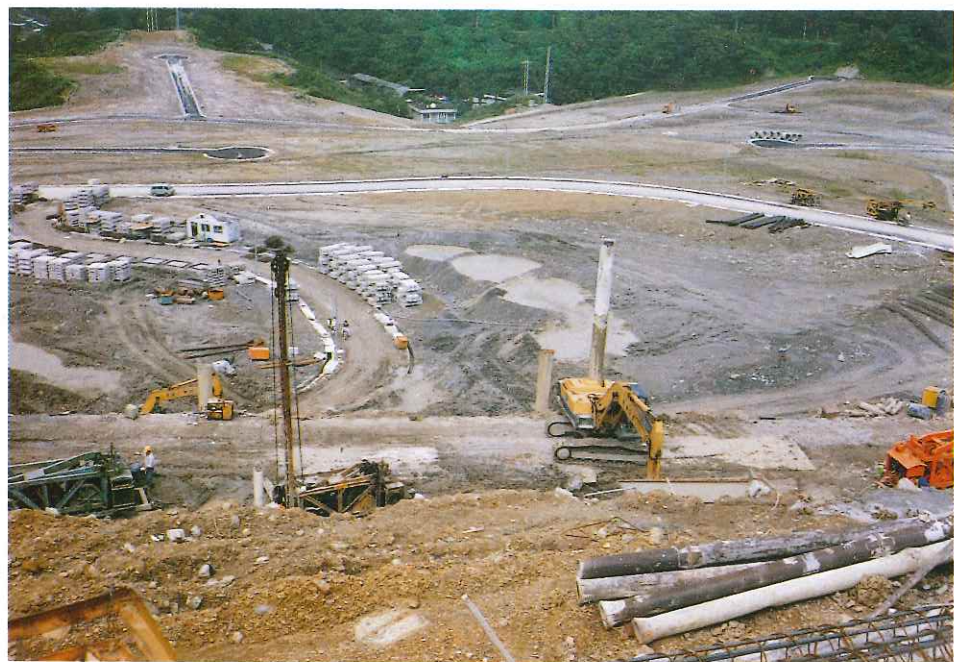
重劃工程施工中
