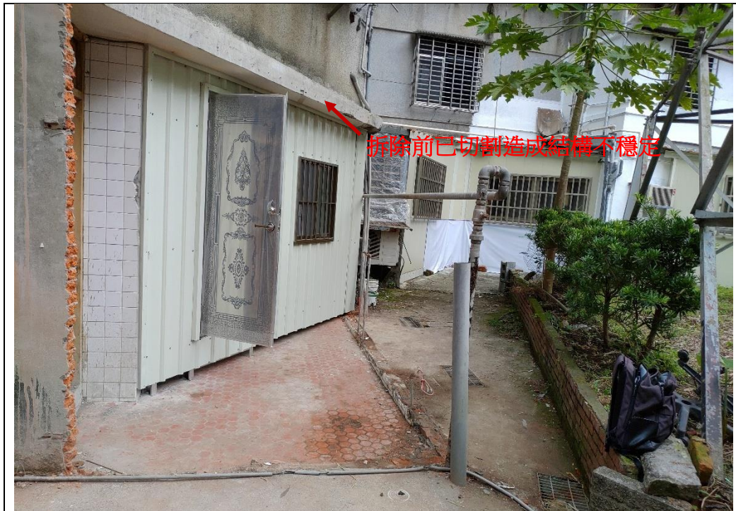
說明一 拆除現場已完工。
