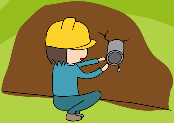
修理地下水管
