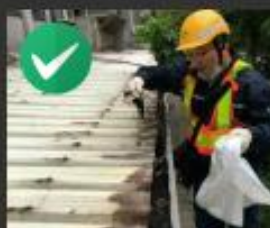
定期清理阻塞的天溝，保持暢通，避免積水
