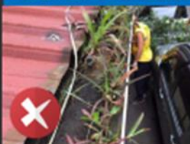
屋簷的排水槽(天溝)
