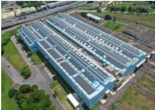
照片 8 土城機廠屋頂（左圖）/蘆洲機廠屋頂（右圖）設置太陽能板
