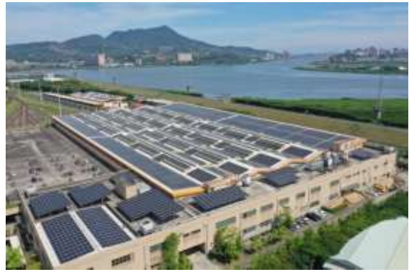
照片 8 土城機廠屋頂（左圖）/蘆洲機廠屋頂（右圖）設置太陽能板
