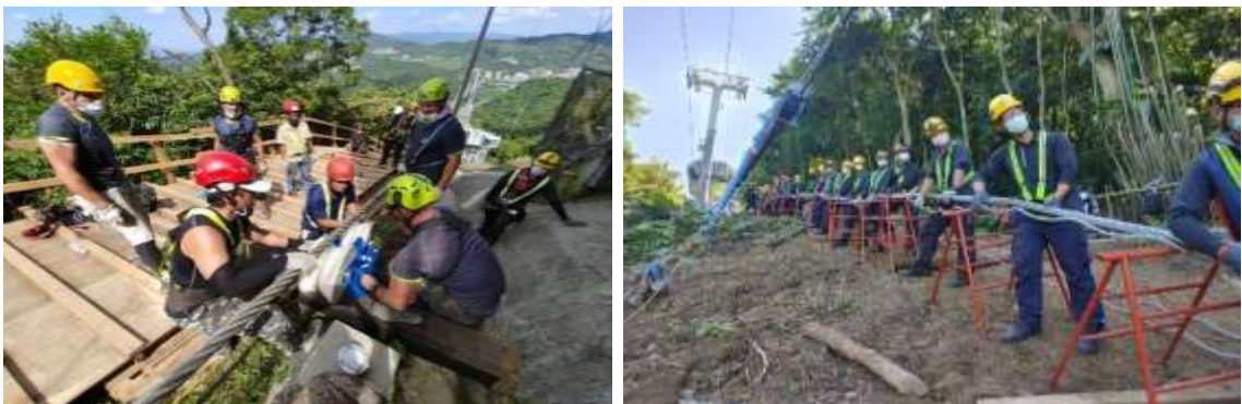
照片 3 換纜作業情形
