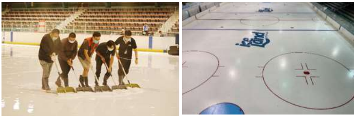
照片 11 小巨蛋冰上樂園融結冰及標線重新畫設作業
