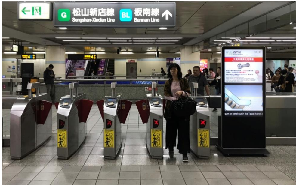
照片 1 捷運車站閘門區建置電子資訊顯示系統
