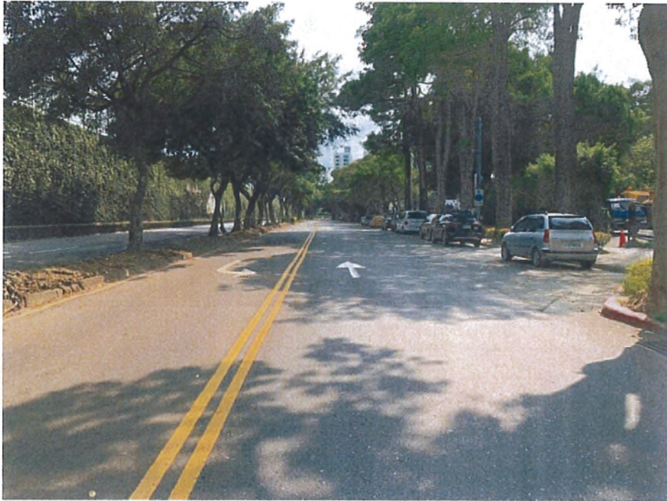
圖 1 水源路道路現況 1
