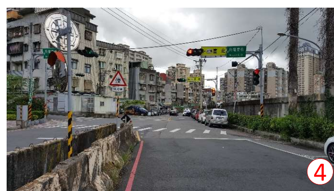
左岸防汛道路及防洪牆
