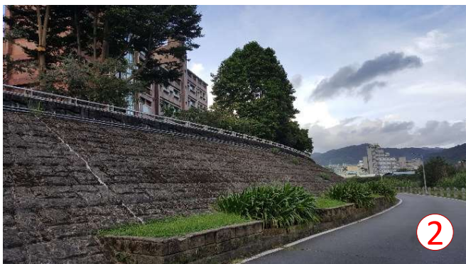
右岸堤外自行車道
