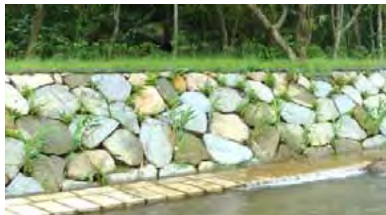
下游段多孔隙堤岸營造
