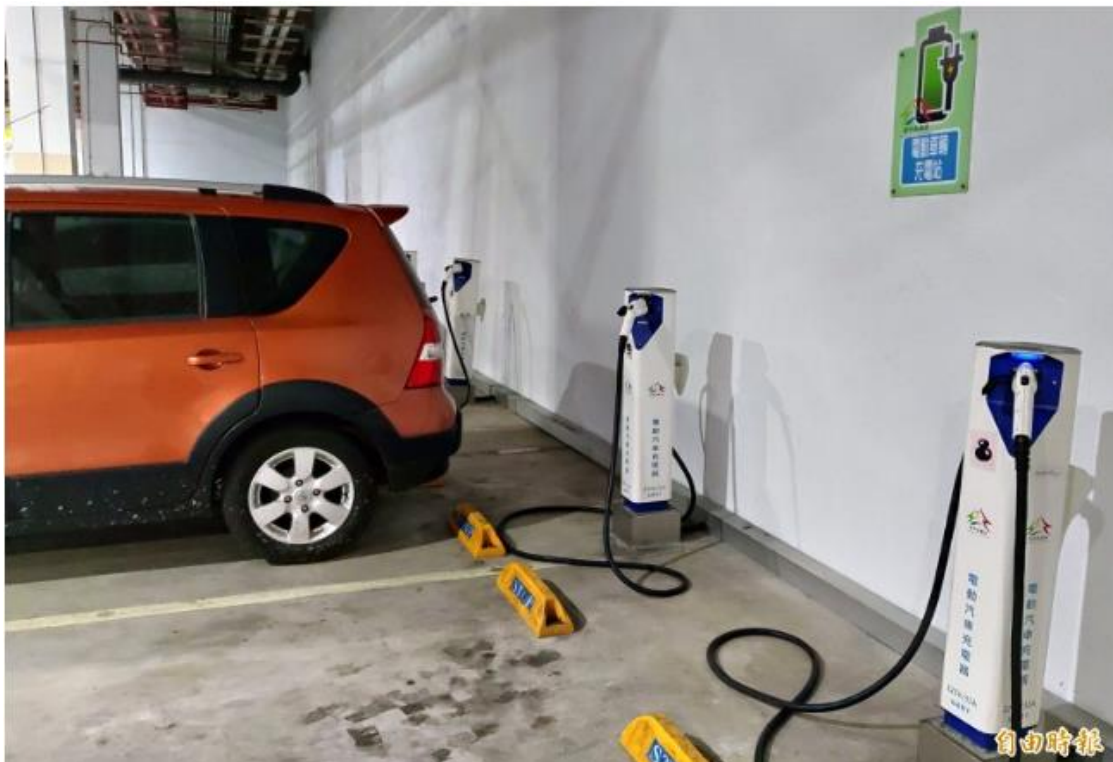
圖 5 業者將充電樁安裝於停車場
