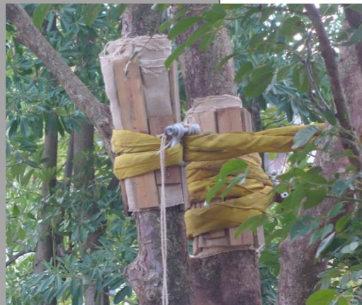
吊掛索具與樹幹之接觸部位應加襯墊包裹保護
