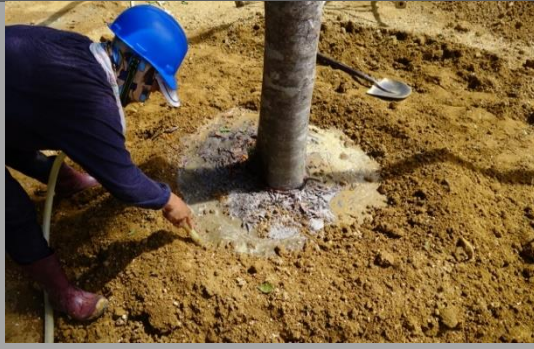
視情況設置集水坑，將土壤灌水搗實
