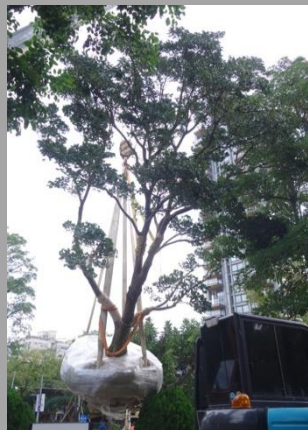
吊掛索具與樹幹之接觸部位應加襯墊包裹保護
