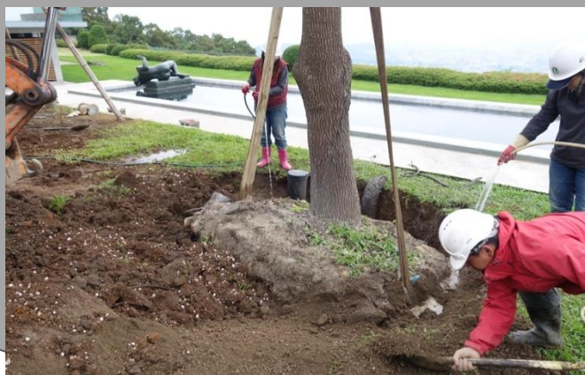
種植後填放砂質壤土，於根球四周均勻地填以表土及客土並壓實
