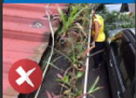
屋簷的排水槽(天溝)
