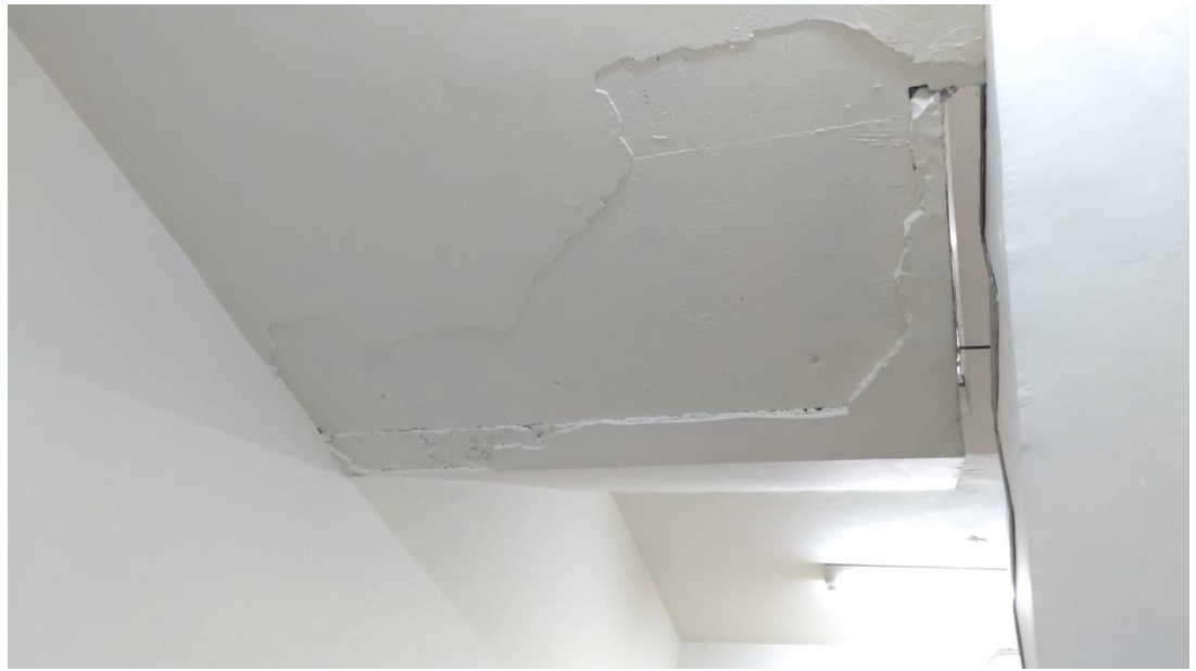
B2F 甲梯間天花板披土油漆
