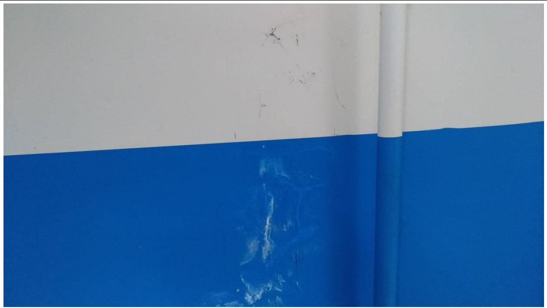
B2F 16 號停車格左側牆面表層壁癌處理油漆復原
