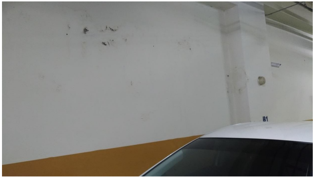
B1F 56 號停車格左側牆面表層壁癌處理油漆復原
