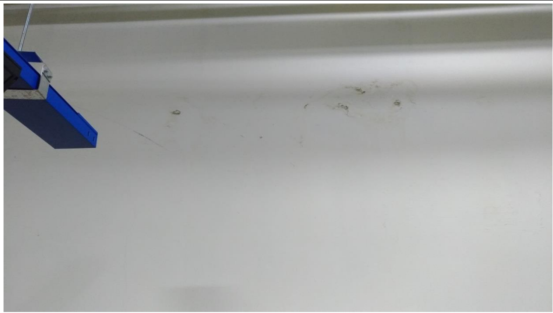
B1F 56 號停車格前方左側牆面表層壁癌處理油漆復原
