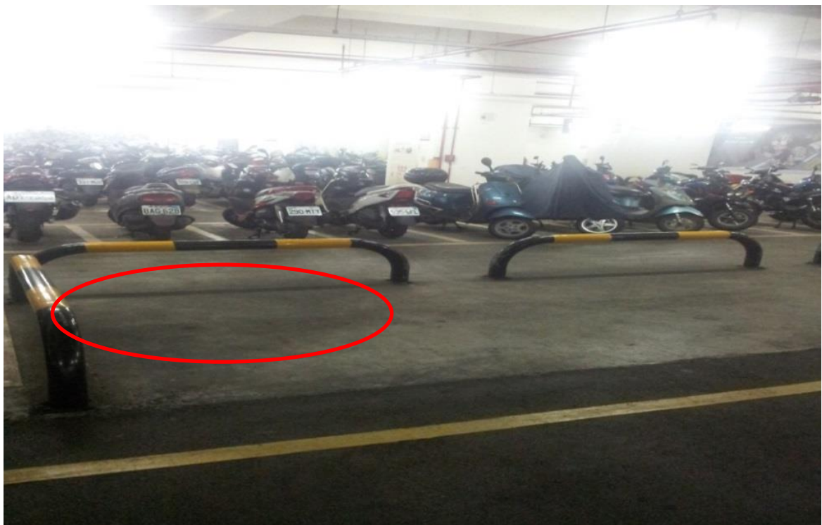
6. 北投區石牌國小地下停車場：致遠 2 路 1 段 80 號地下
