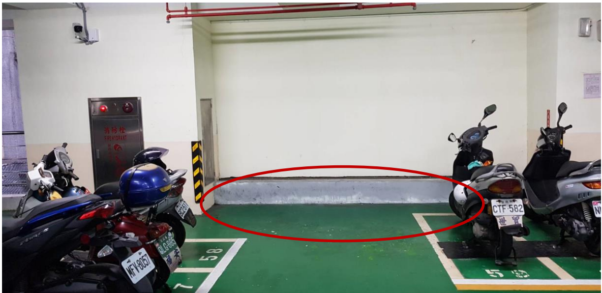
28. 大湖公園地下停車場:成功路5段7號地下
