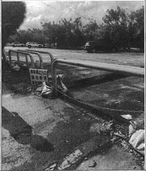
原缺口處設備拆除
