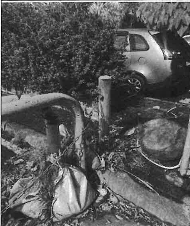
原缺口處設備拆除
