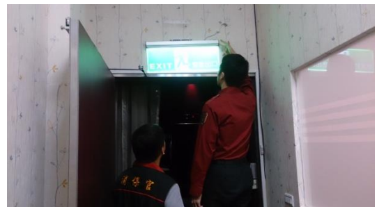
國賓戲院@長春廣場消防檢查
