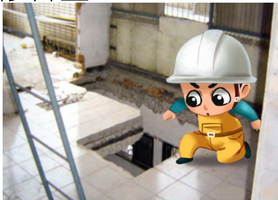
拆除樓地板涉及主要構造之變更
