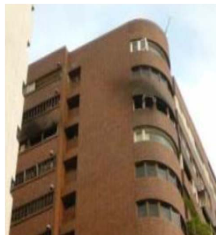
室內裝修施工過程擅自剪斷火警警報系統並封閉灑水頭致災
