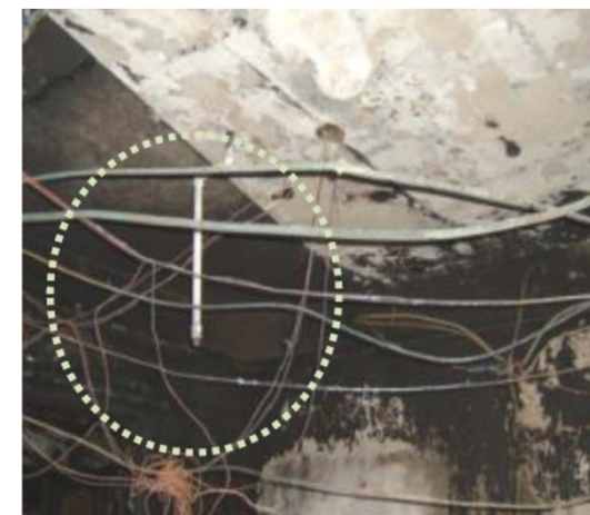
室內裝修施工過程擅自剪斷火警警報系統並封閉灑水頭致災
