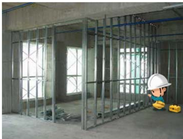
輕鋼架隔間牆具有良好的防火、防潮、耐撞擊力、耐震性，隔音效果佳
