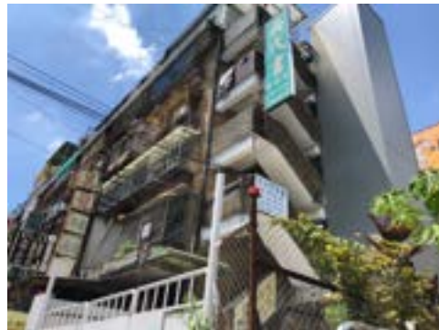
目前正在進行中的劍潭整宅二期的增設電梯計畫
