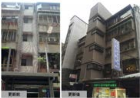
大安區和平群賢華廈增設電梯整建前後對照
