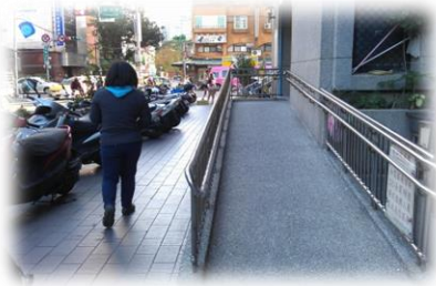
無障礙斜坡道
