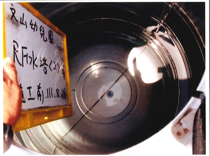
頂樓水塔-2 施工前
