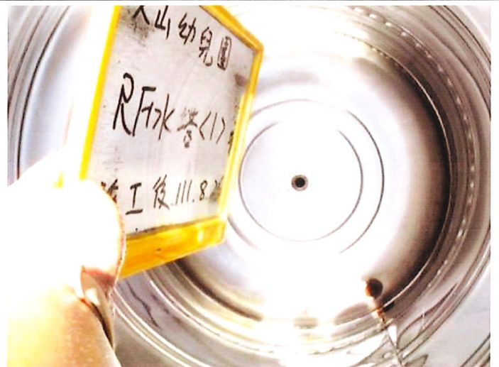
頂樓水塔-1 施工後
