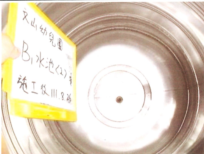
B1F 蓄水池-2 施工後
