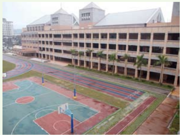
▲南港國小校舍新建工程
