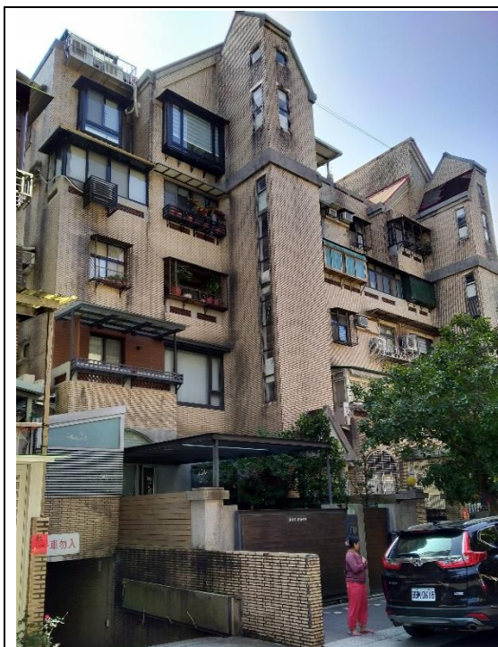
臺北市松山區健康路 (宏泰御林園社區)施工前
