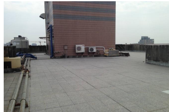
屋頂避難平台
