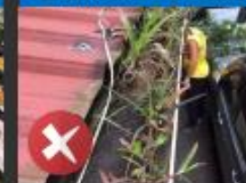
屋簷的排水槽(天溝)
