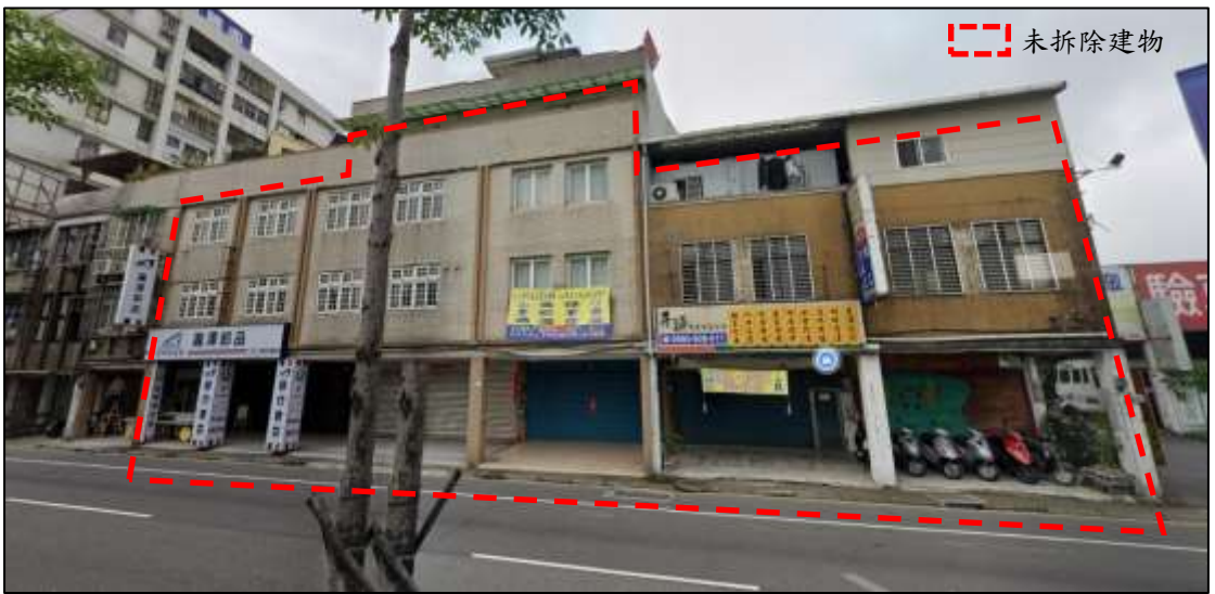
圖 3 未拆除建物之現況
