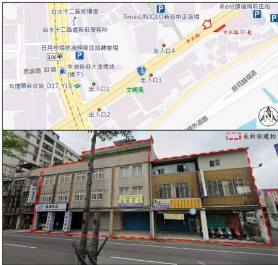
圖 2 未拆除建物之現況
