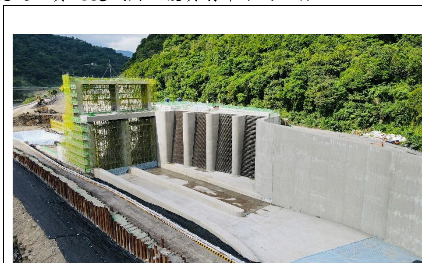
取水口引水路及排砂道
