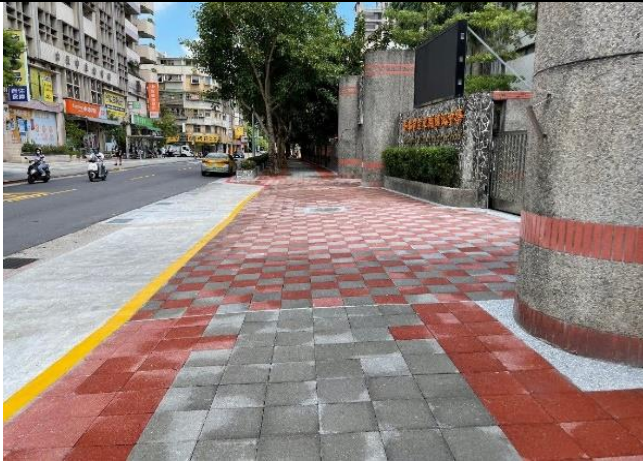
內湖區東湖國中周邊人行道改善工程
