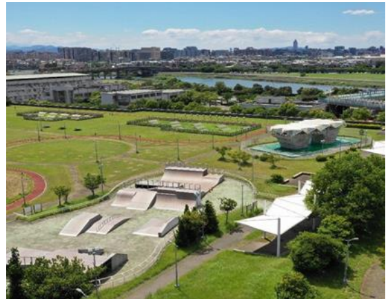
內湖污水處理廠
