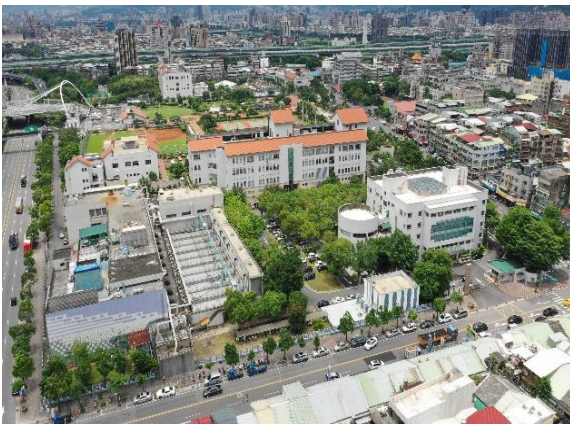
迪化污水處理廠
