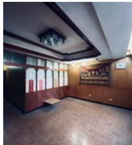
01 整建維護前現況照片
