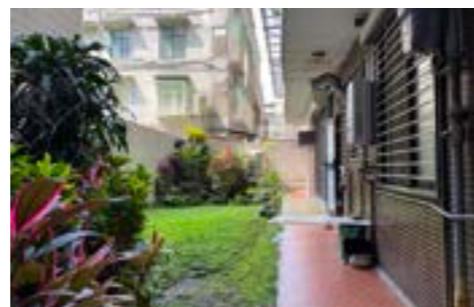
02 整建維護前現況照片
