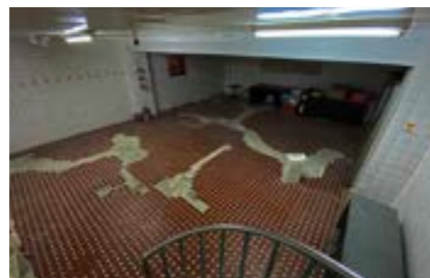
01 整建維護前現況照片
