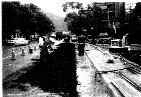
恢復人行道,側溝及鋪設柏油
