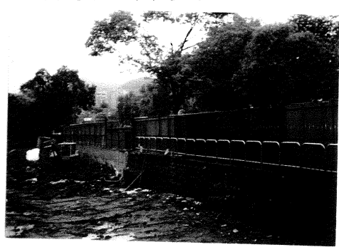
基地整地作業 基地與道路地坪落差約3公尺 第4頁
