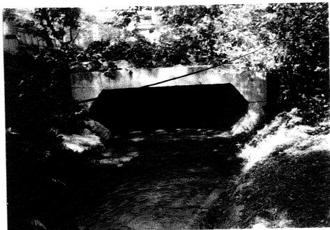
溝渠改道完成(箱涵進水口)
