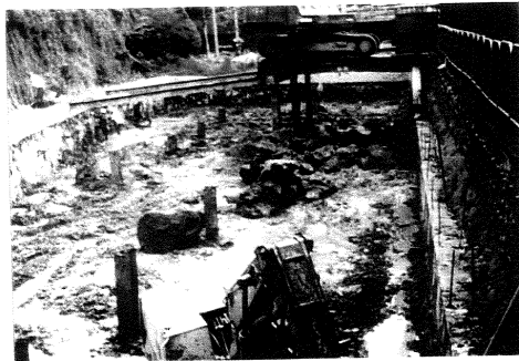
地下室底部筏式基礎配筋作業 第6頁
