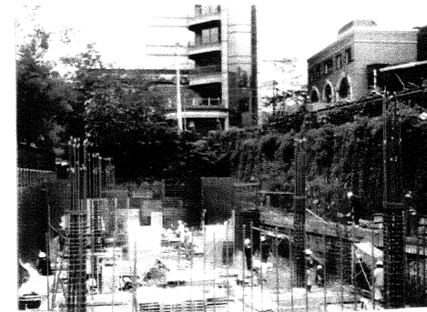
地下室筏式基礎頂部配筋及模板作業 第7頁
