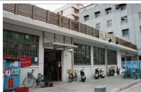
大直市場外牆整修後
