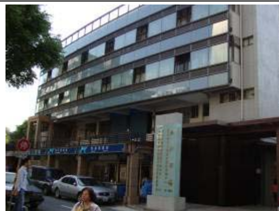
松江外牆整修後
