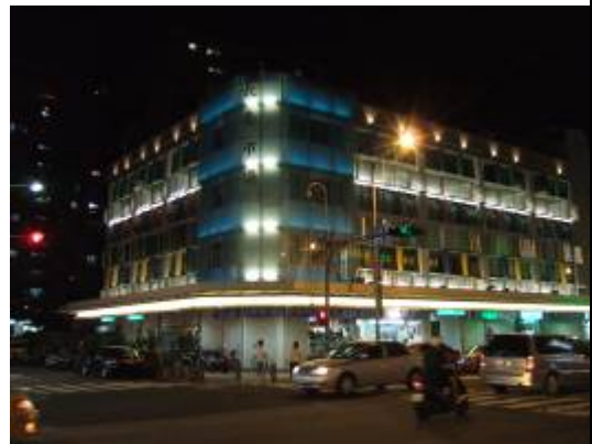
長春市場外牆整修後
