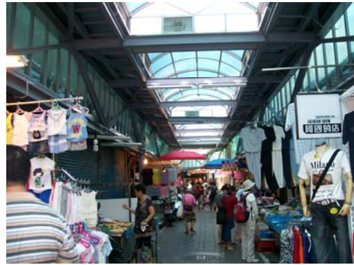
景美街遮雨棚現況
