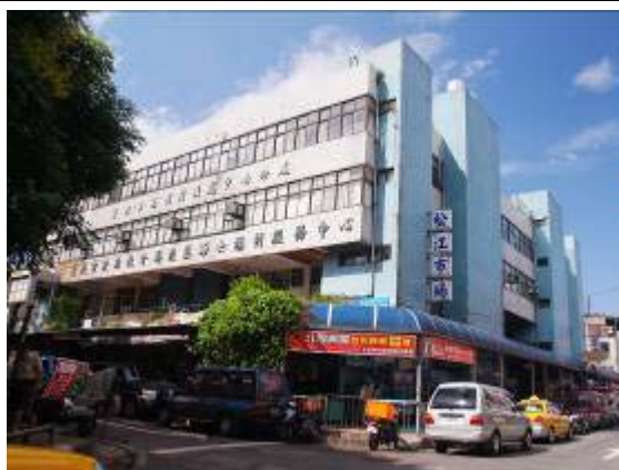
松江外牆整修前
