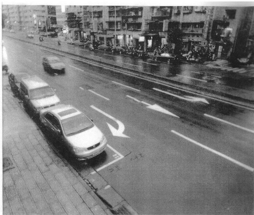
附圖 B-2 萬大線 LG03 北側現場實景 西藏路現有停車格寬 2 米+縮減車道 0.4 米=2.4 米 可設置一個像附圖 B-1 2.4 米寬的單向電扶梯出口
