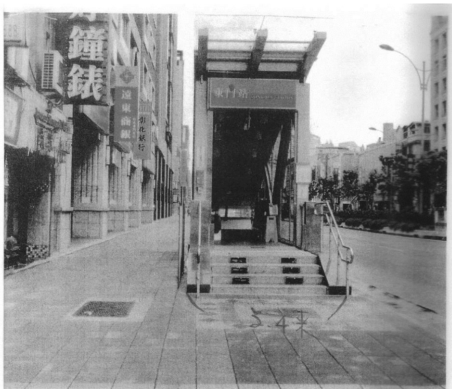
附圖 B-1 蘆洲線東門站 1 號(2.4 米寬)單向電扶梯出口 ( 寬 2.4 米 x 長 20 米 )
