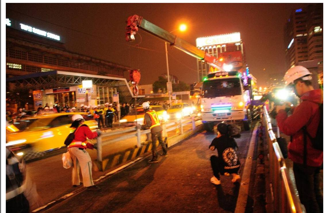
型鋼護欄吊放
