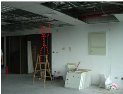
模擬當時罹災者站在合梯上拆除燈具電線並以膠帶包覆
