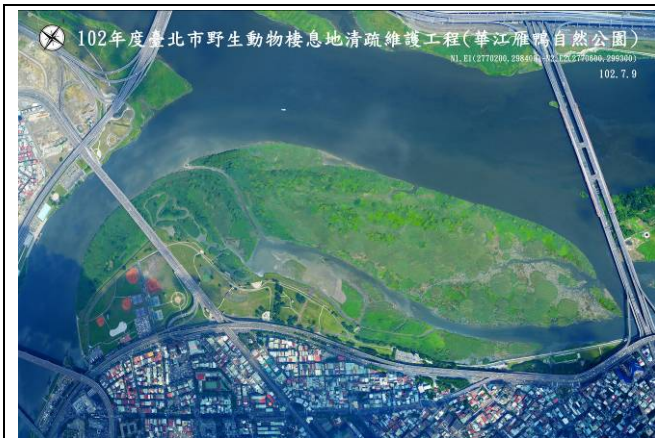
102 年華江雁鴨自然公園清疏維護工程 施工後正攝拼接圖
