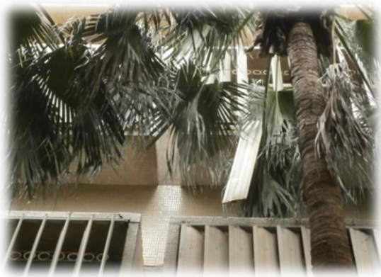
圖1-遮陽板破損
