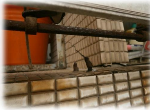
圖2-窗臺鋼筋鏽蝕
