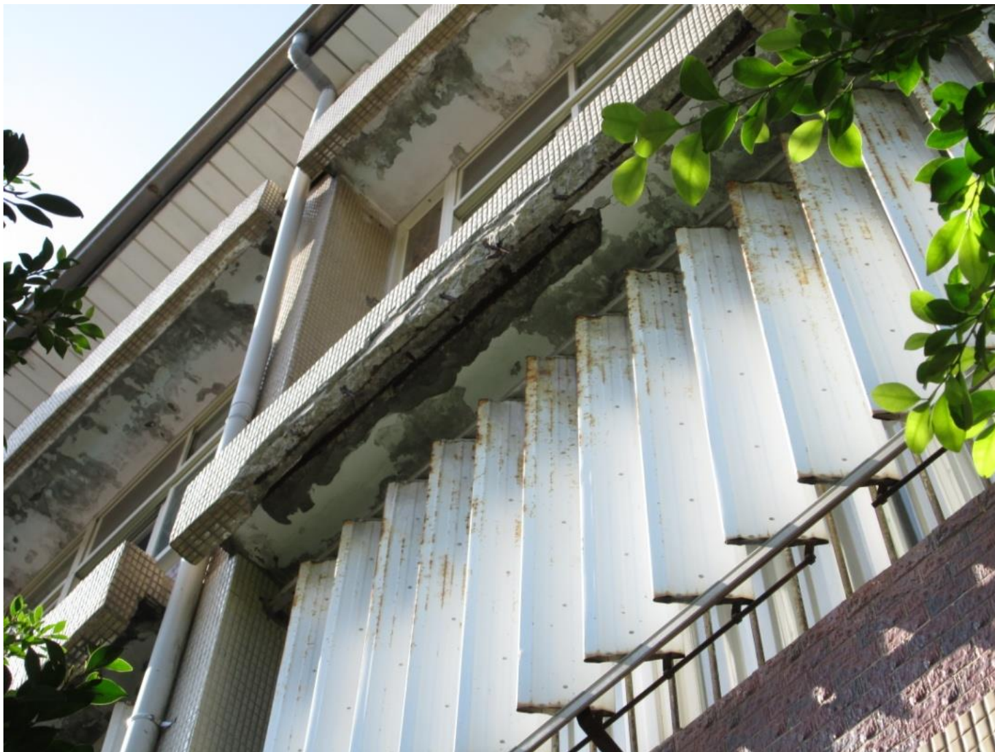
原有可旋轉式金屬遮陽板銹蝕脫漆損壞
