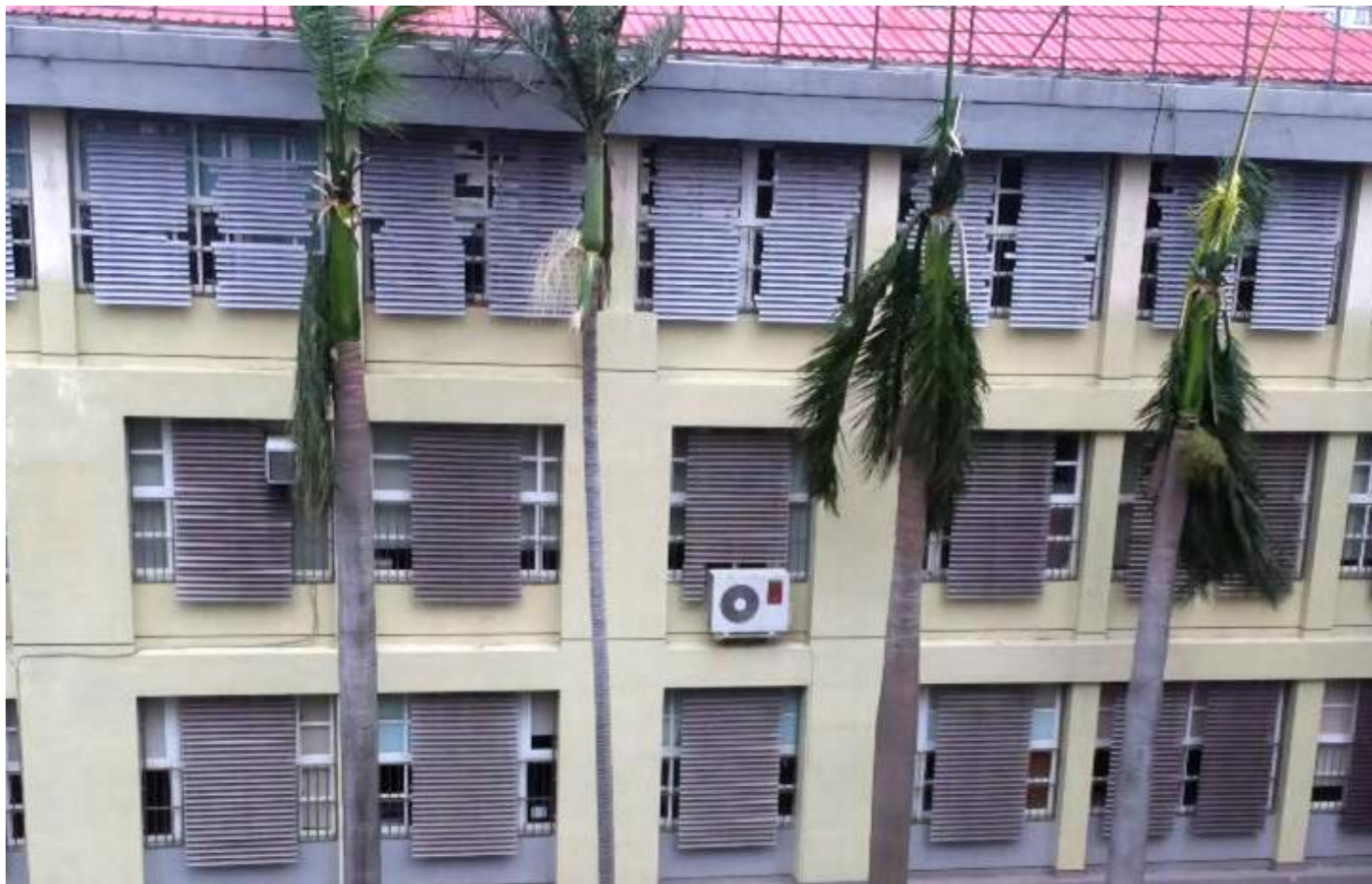
蘇迪勒13級以上強風造成樹枝破壞遮陽板
