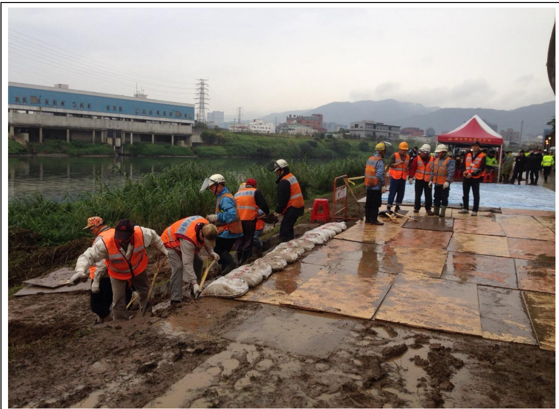
鋪設木板，通道清理
