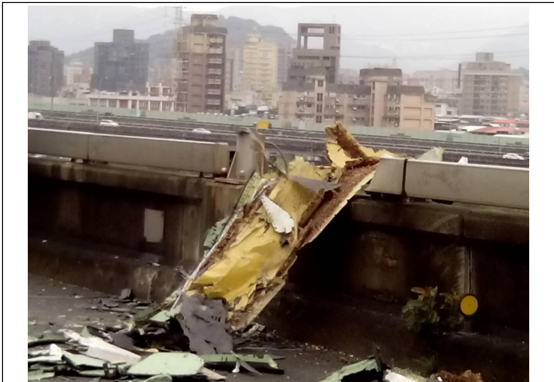
現場機翼殘骸、不鏽鋼護欄及路燈受損情形
