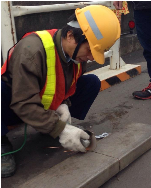
不銹鋼護欄損壞施工中
