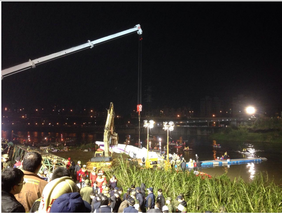
吊車執行機身殘骸吊離河面作業
