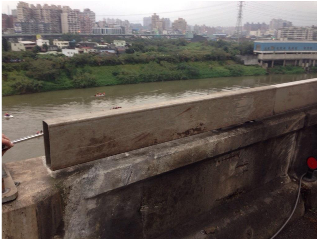
不銹鋼護欄損壞部份已修復完妥（2月4日17時16分）
