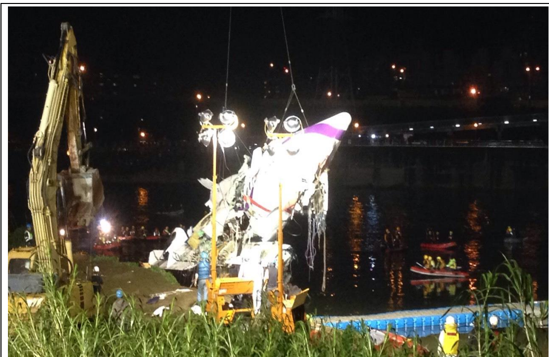
吊車將機頭吊至岸邊
