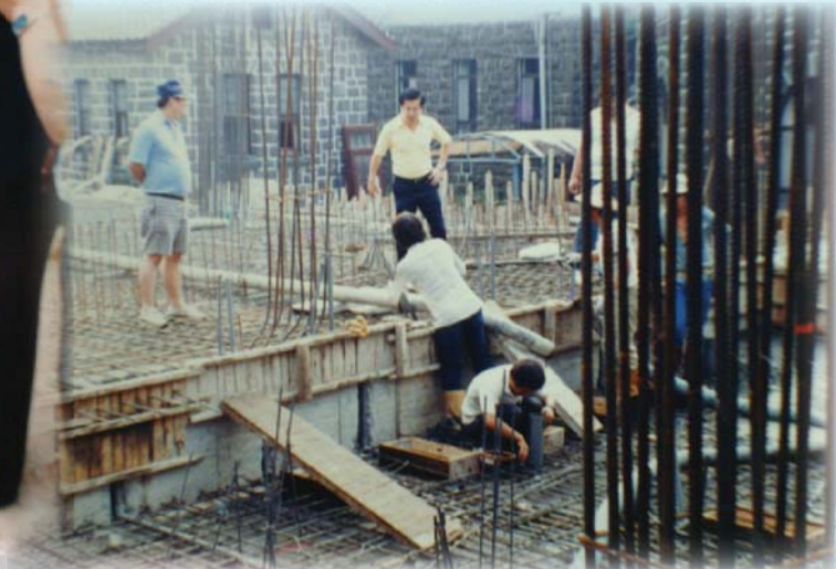
▲ 74.12 綜合大樓施工(卓英豪副主任巡視工地)
