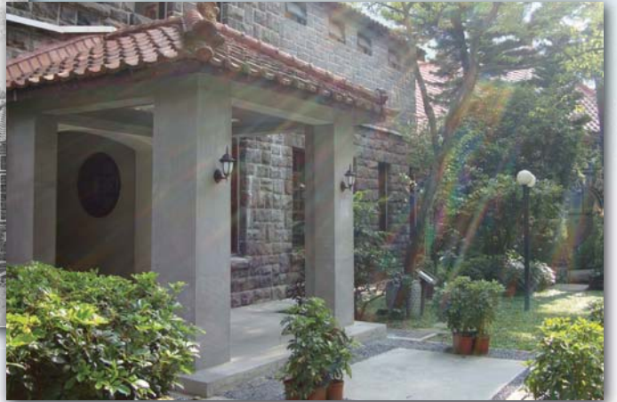
▲100.8.18 行政大樓現貌
