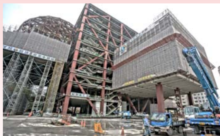
104年1月施工照片
