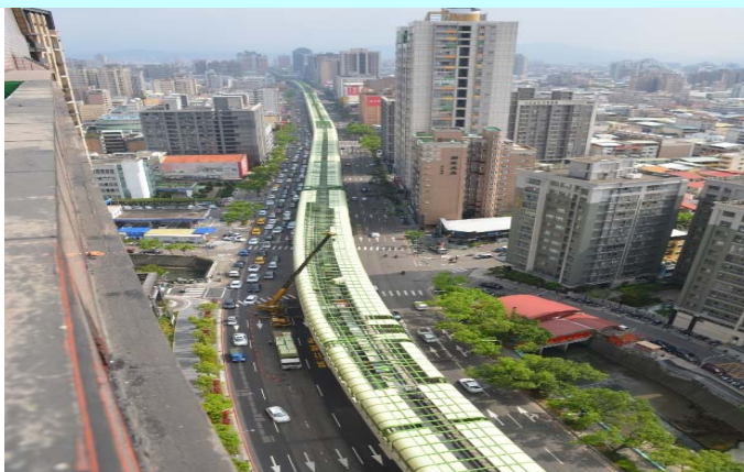
台中捷運高架段合龍完成
