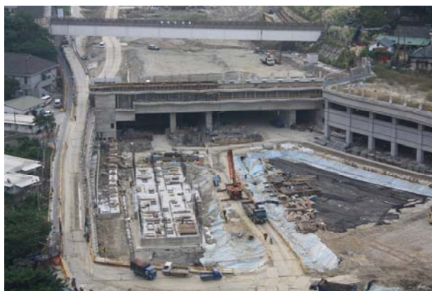
新莊機廠明挖覆蓋隧道延伸段及地面層施工現況
