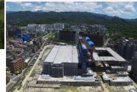
105年11月施工現況
