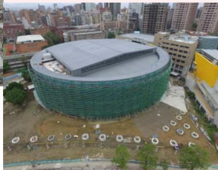
105年11月施工現況
