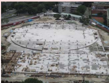
104年1月施工照片
