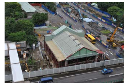
101.05 臺北工場挪回完成
