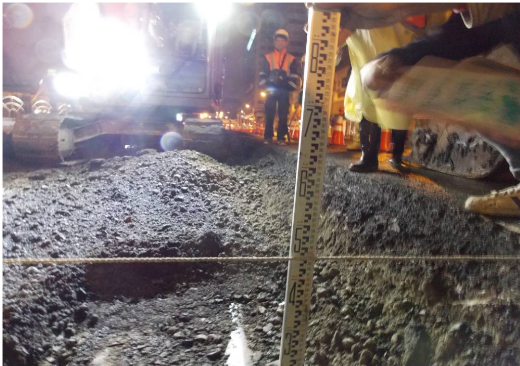
量測開挖深度
