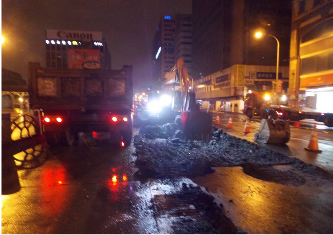
挖除路基軟弱土壤
