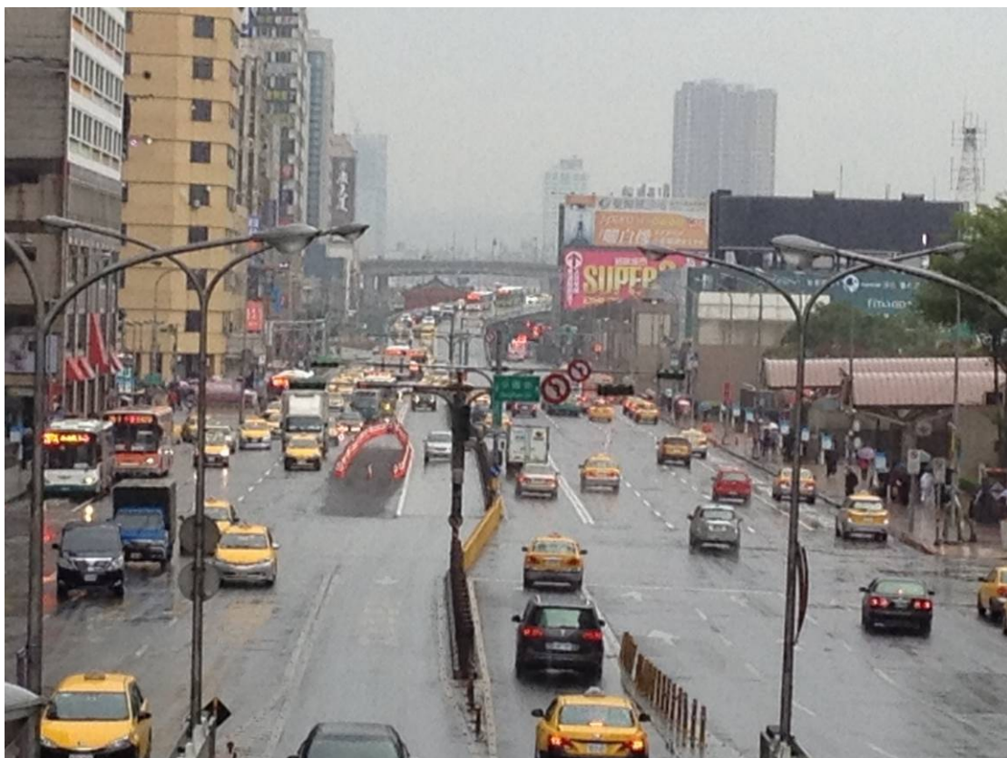
施工前臨時路面交維情形
