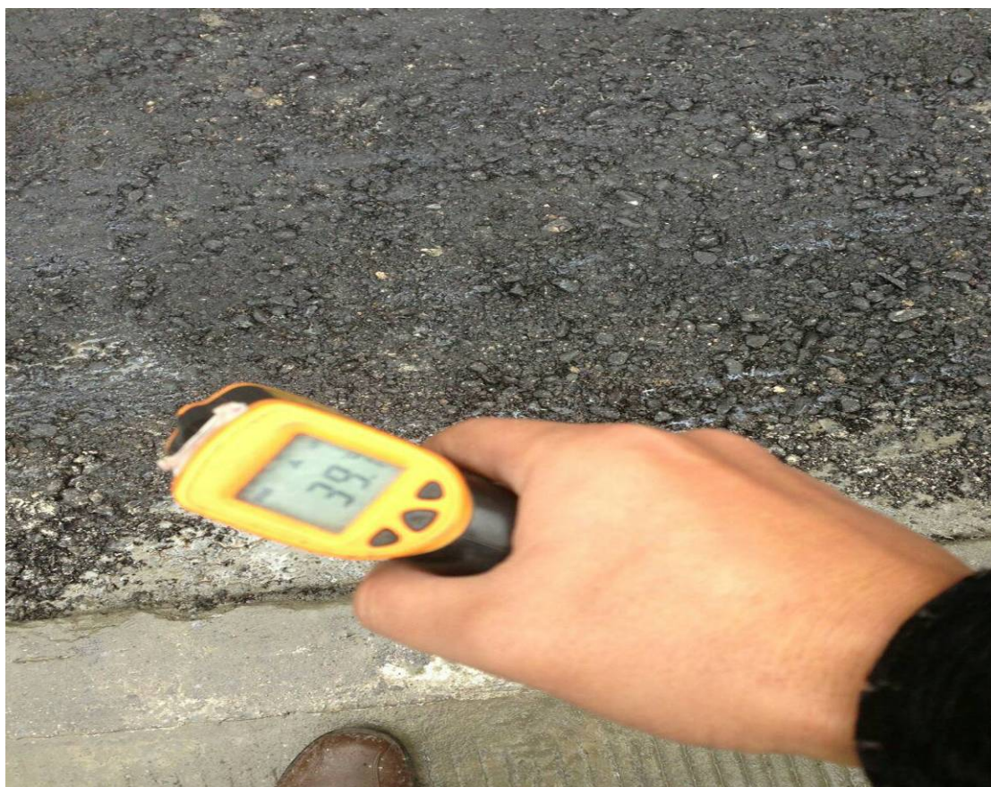
檢測瀝青混凝土路面溫度
