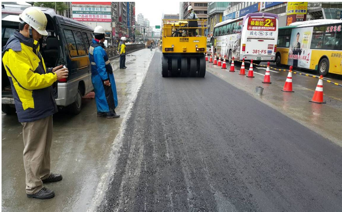
滾壓路面瀝青混凝土
