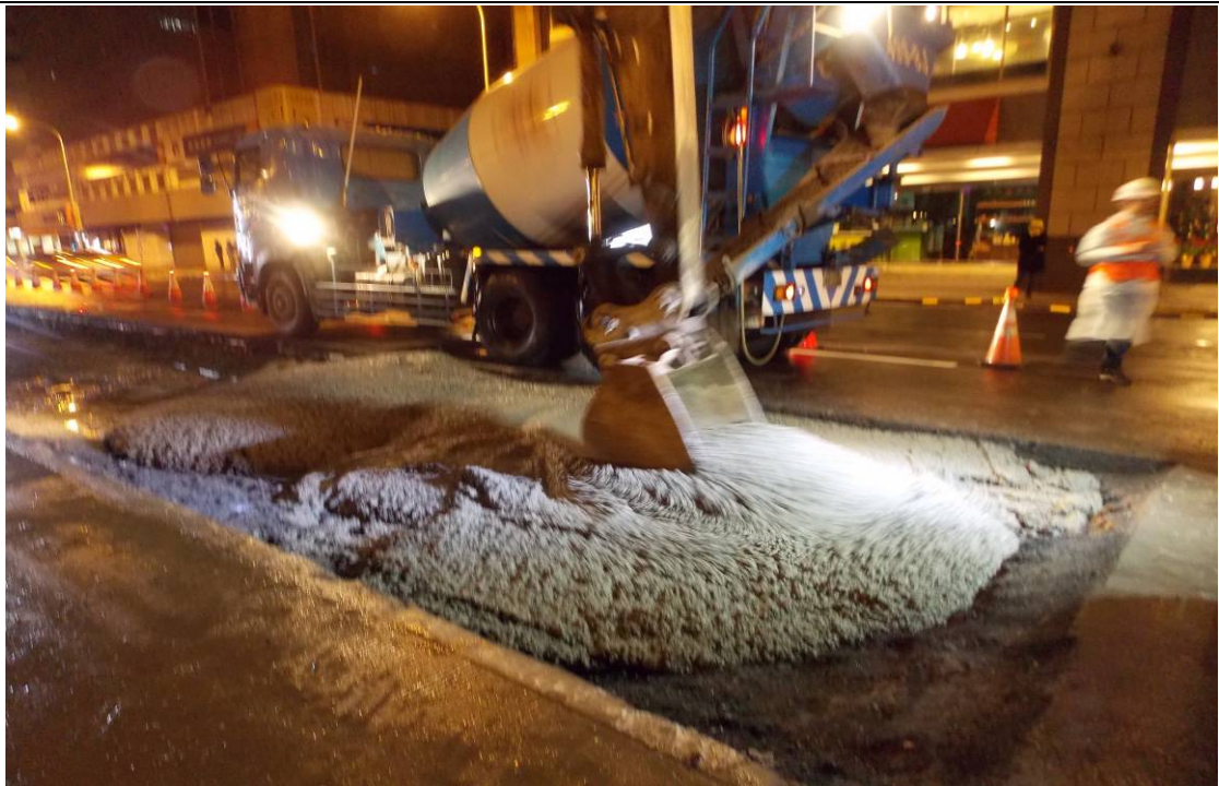
澆置早強混凝土
