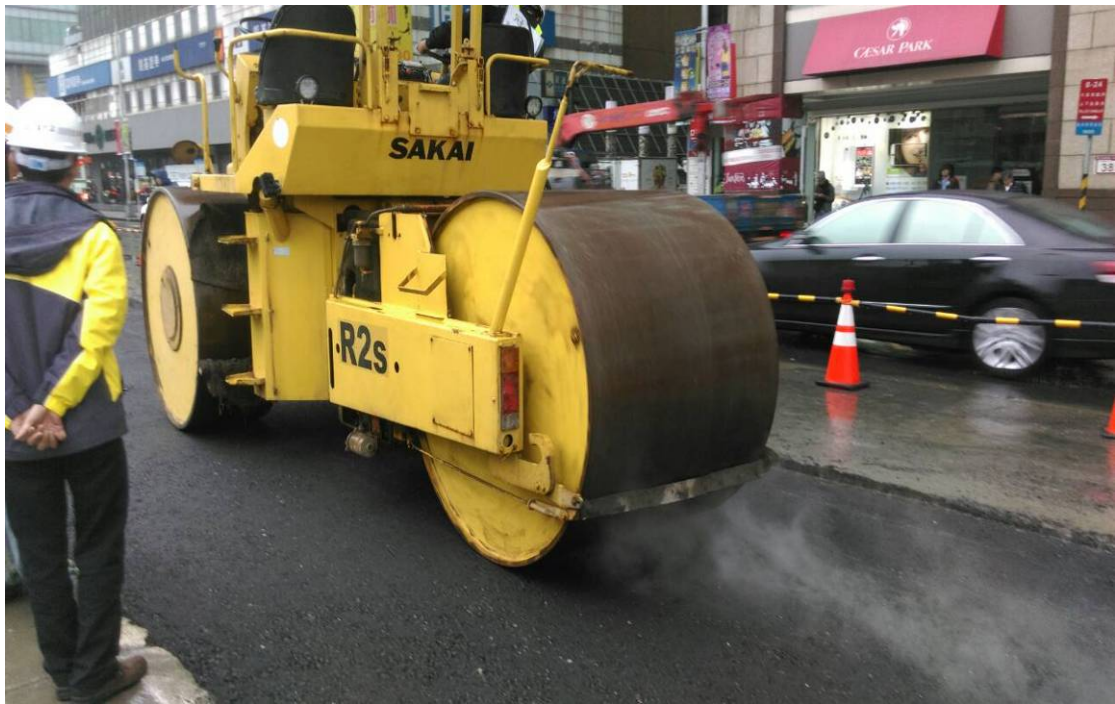
滾壓夯實路面瀝青混凝土
