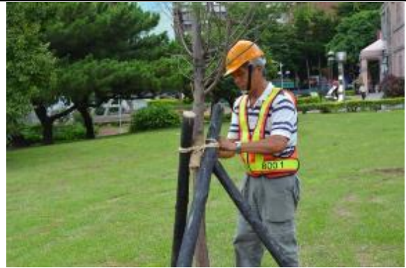
4. 樹幹與支柱間加透氣襯墊（麻布或麻纖維毯），再用麻繩以8字型方式網綁
