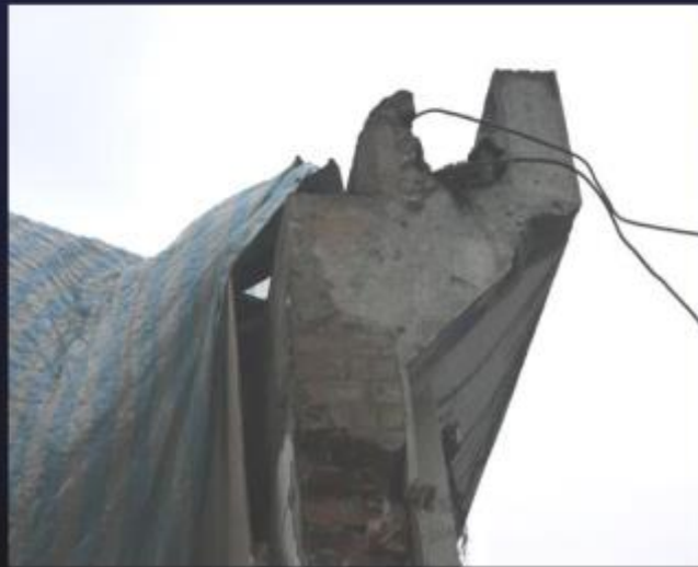
天溝構造與RC梁共構
