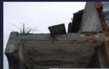
RC梁配筋於上層，可能肇致梁抗載重能力不足，產生下沉撓曲。
