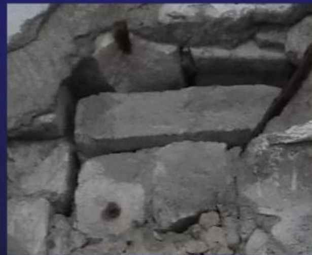
RC梁配筋於上層，可能肇致梁抗載重能力不足，產生下沉撓曲。
