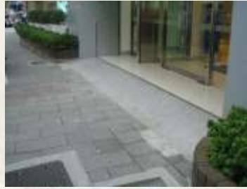
避難層出入口
