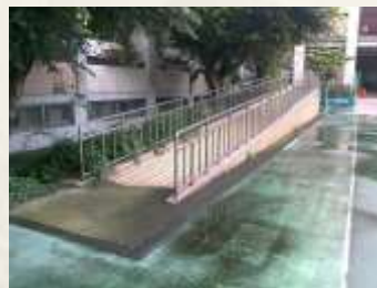
避難層坡道及扶手
