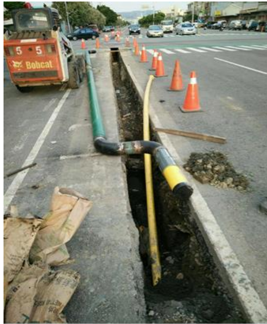
圖 4-9 工程案例二現地照片(灌漿前)
