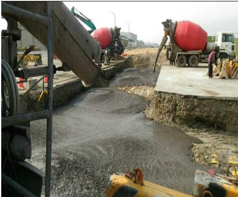
圖 4-7 工程案例一現地照片(灌漿中)
