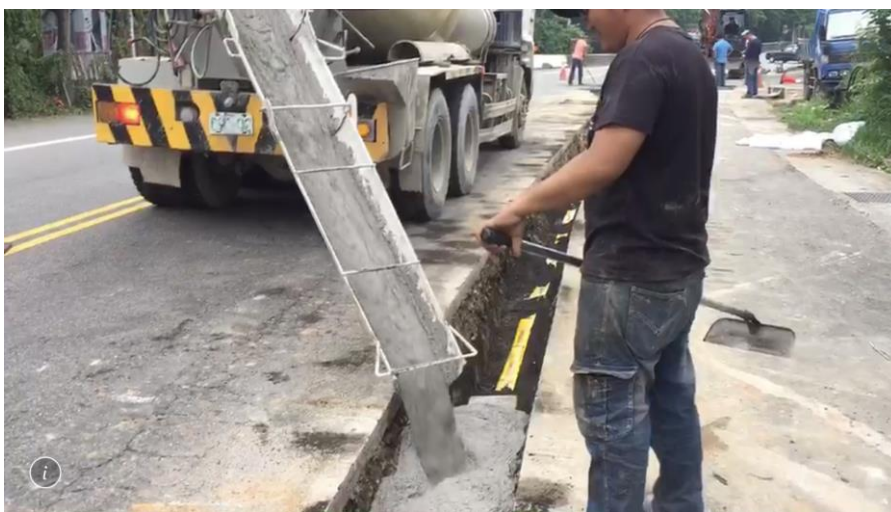
圖 4-14 工程案例四現地照片(灌漿中)
