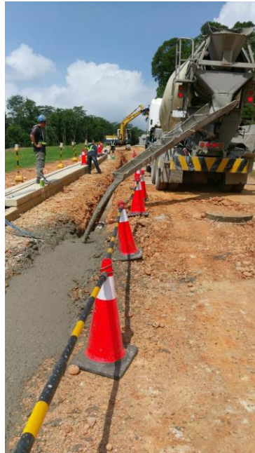
圖 4-12 工程案例三現地照片(灌漿中)
