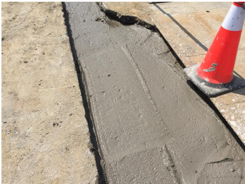
圖 4-13 工程案例三現地照片(灌漿後)
