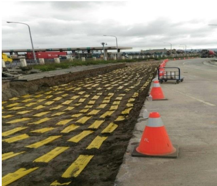
圖 4-6 工程案例一現地照片(灌漿前)
