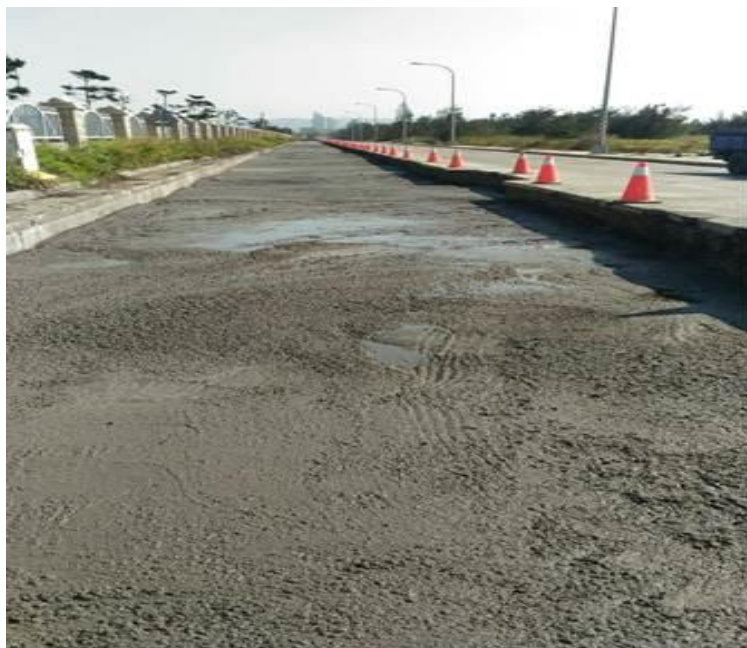
圖 4-8 工程案例一現地照片(灌漿後)
