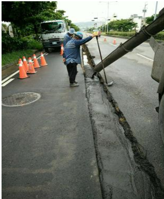
圖 4-10 工程案例二現地照片(灌漿中)
