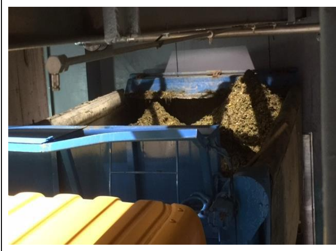
圖 5. 固渣掉落載運卡車斗之情形
